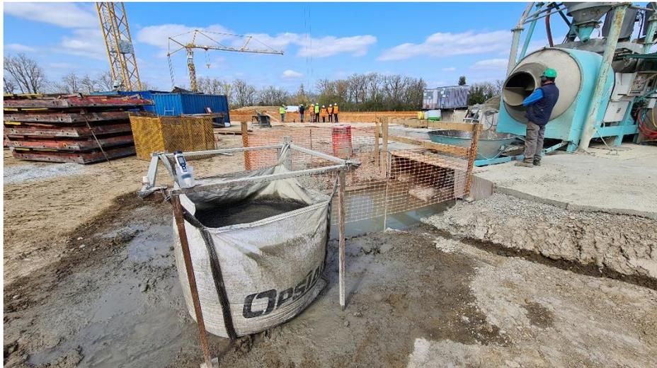
Exemple de système de collecte & filtration des laitances de béton sur un chantier :
